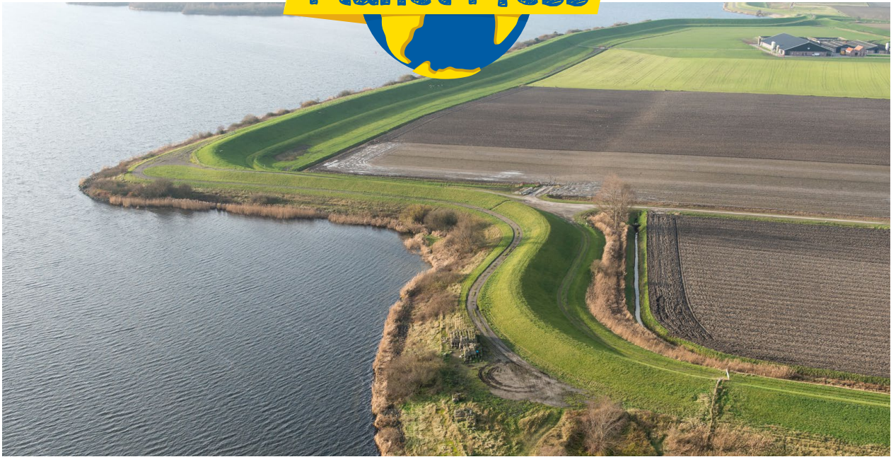
Luftbild eines Deiches in den Niederlanden, der Ackerland schützt, das unter dem Meeresspiegel liegt. Bildrechte: Rijkswaterstaat, Ministerium für Infrastruktur und Umwelt, Niederlande.
